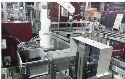
Taizhou Juli handling project
